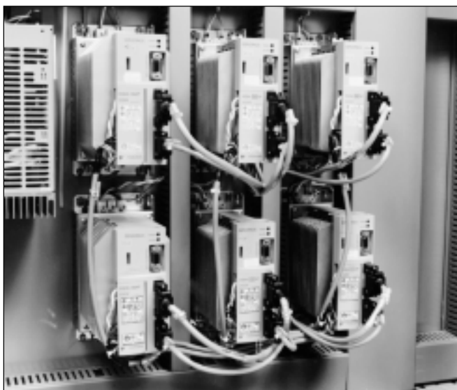
Et kik ind i et af styreskabene med 6 Yaskawa servodrivere
