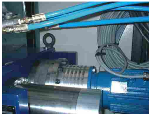
Fig. 5.5a: Example of bearing reducer's cooling / Ein Beispiel für Getriebekühlen
